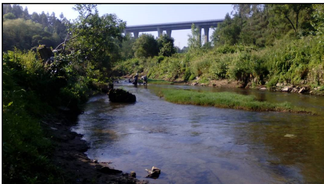
P1 – Troço do rio Ferreira a montante da descarga das águas de escorrência da Ponte sobre o Rio Ferreira II – pk 11+614 / 11+874
